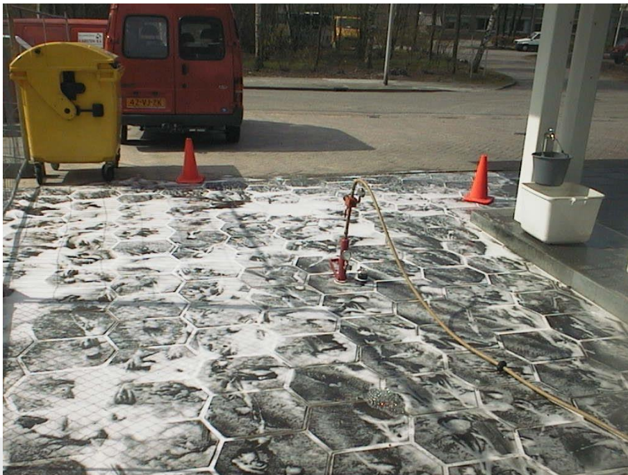
Foto: Inspectie uitgevoerd overeenkomstig protocol 6704.
